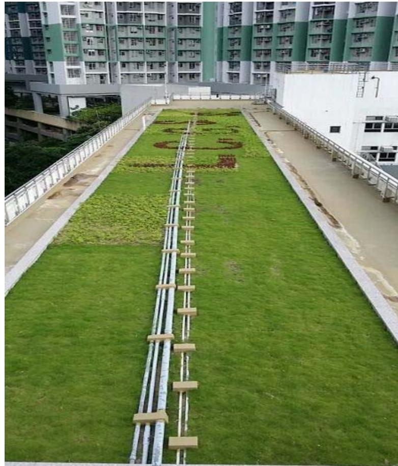
ガーデンクリートは天然の軽石を無機系の固化材で固めた緑化基盤なので、ウレタンや植物を使用した有機系の緑化基盤よりも耐候性、耐火性に優れ、屋外で長期にわたって使用しても紫外線や雨水による劣化が見られません。文京区の建物のテラスでガーデンクリート緑化システムの上で様々な植物を育て5年目に入りました。
