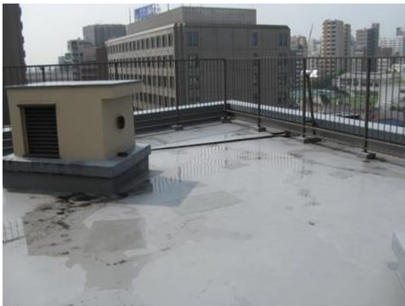
ガーデンクリート施工前の屋上
