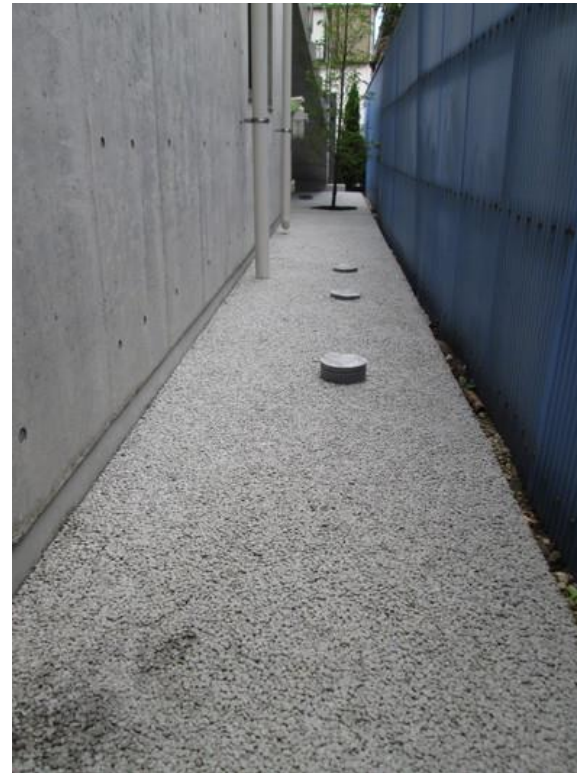
ブミコン舗装後
