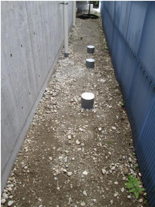
ブミコン舗装前
