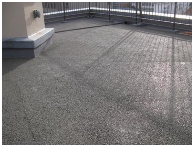
ガーデンクリート施工後の屋上
